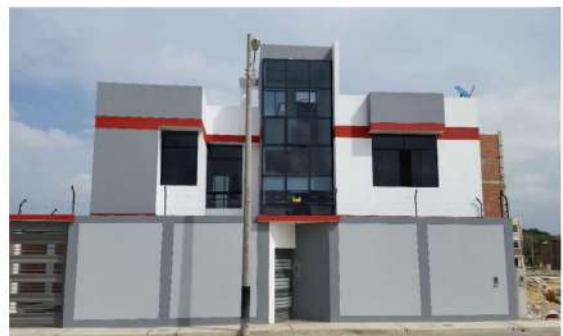
CONSTRUCCION DE VIVIENDA UNIFAMILIAR EN URB. MIRAFLORES COUNTRY CLUB
