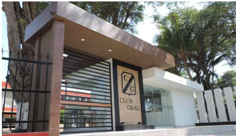
REMEDIACIÓN DEL INGRESO PRINCIPAL Y SECUNDARIA DEL CLUB GRAU DE PIURA
